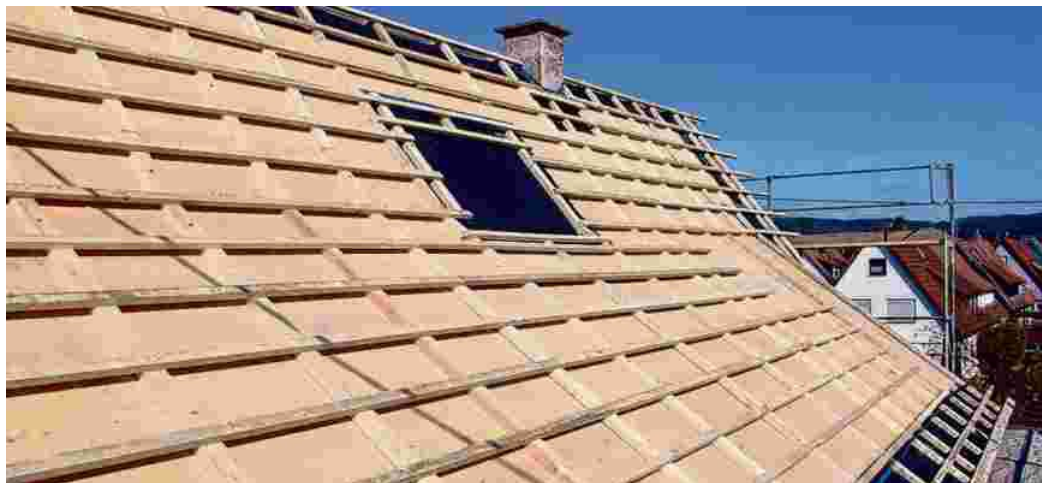
Auch die Dämmung von Dächern und obersten Geschoßdecken bieten deutliche Einsparungspotenziale.
