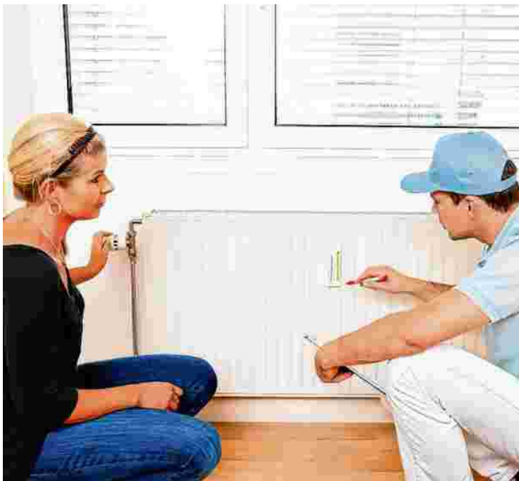
Das Entlüften der Heizkörper hilft sparen.
